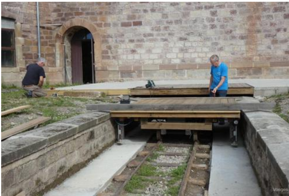
La scène et la réfection de la voie de 60 sont actuellement les deux gros chantiers des bénévoles du comité des fêtes, au fort.
