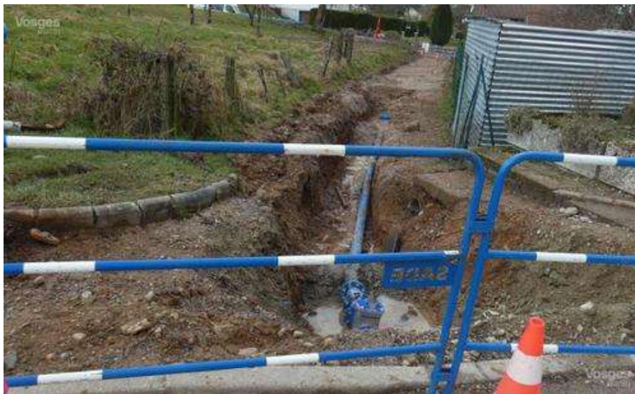
La ruelle menant de la rue de la Libération à la rue du Pont-Tournant connaît actuellement des travaux de changement de canalisation.
