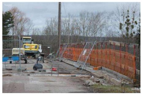
Les garde-corps d'origine ont été retirés pour être rénovés et remplacés par des provisoires, mettant ainsi en sécurité le passage des piétons.
