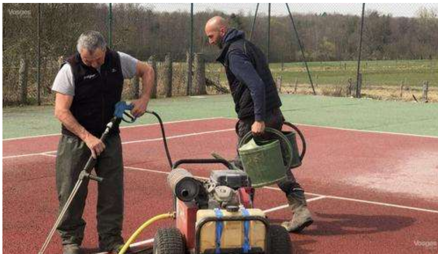
L'entreprise Polytan d'Amiens est actuellement sur les courts, rue de la Libération, pour la réfection du terrain n° 3.
