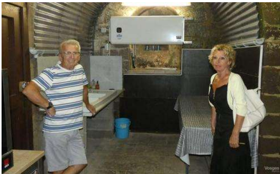
Vice-président et présidente étaient sur place, au fort, pour constater les travaux de la mise en place d'un nouveau chauffe-eau.
