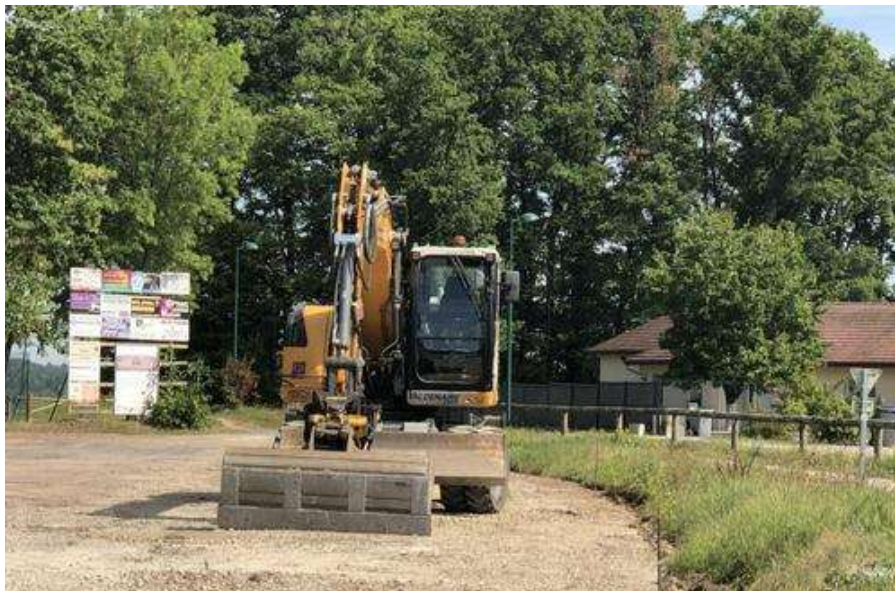
Le parking de droite et l'accès à la porte du fort sont en cours d'aménagement.
