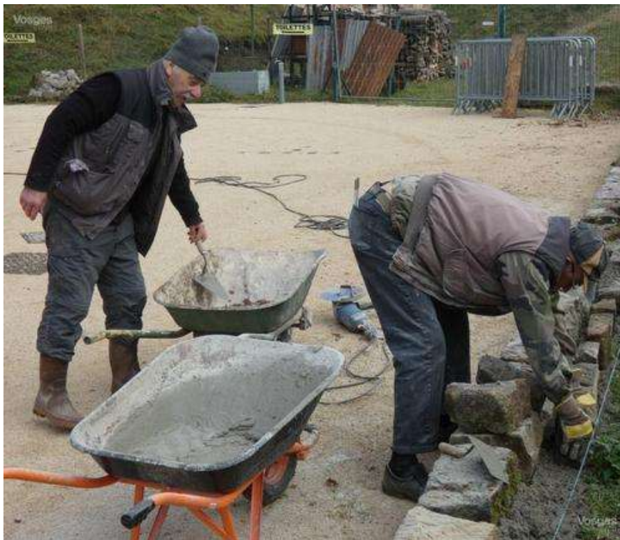
Cette année, les bénévoles du fort ont réalisé la pose de murets de chaque côté des gradins du théâtre de verdure.
