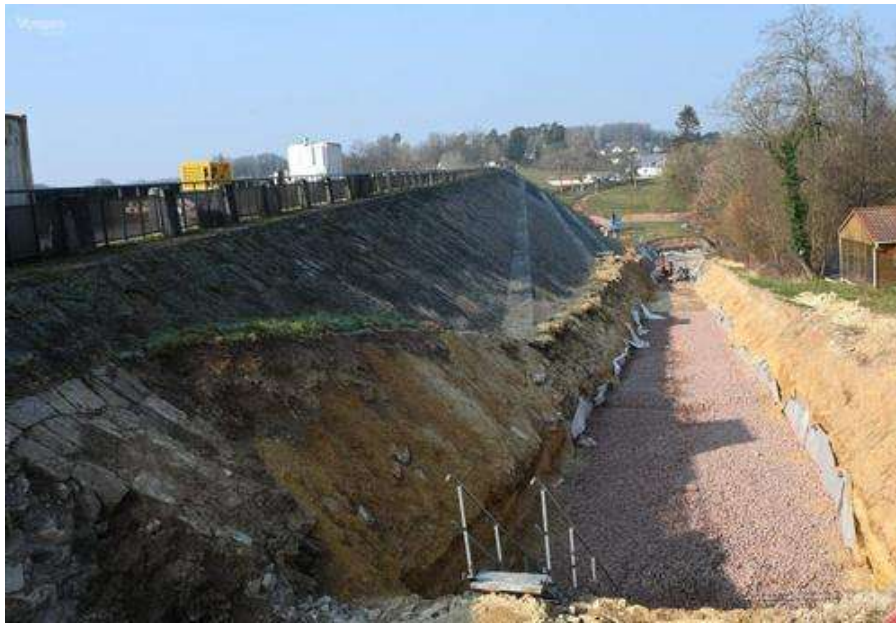
Le gros des travaux destiné à construire un nouvel évacuateur de crue vient de débuter. Photo VM /Eric THIEBAUT
