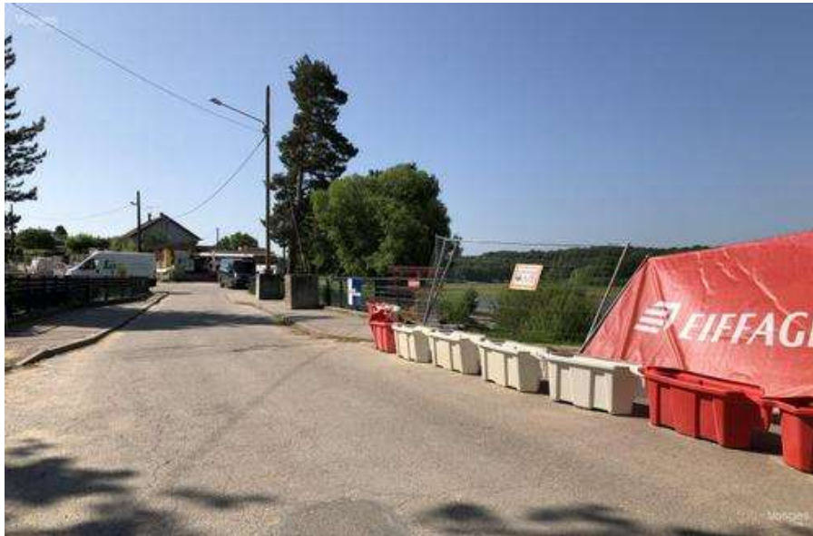
La rue du Lac sur le secteur de Bouzey sera fermée pour cause de travaux du mardi 30 mai au vendredi 9 juin.
