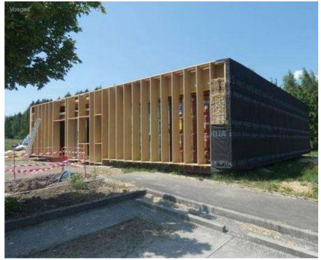
Actuellement, c'est la pose de la paille pour l'isolation extérieure qui est réalisée par l'entreprise concernée, mais également les cloisons à l'intérieur du bâtiment.
