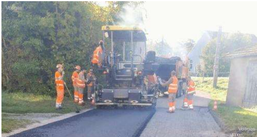
Phase finale des travaux, rue de l'Avière, où les enrobés ont été posés.
