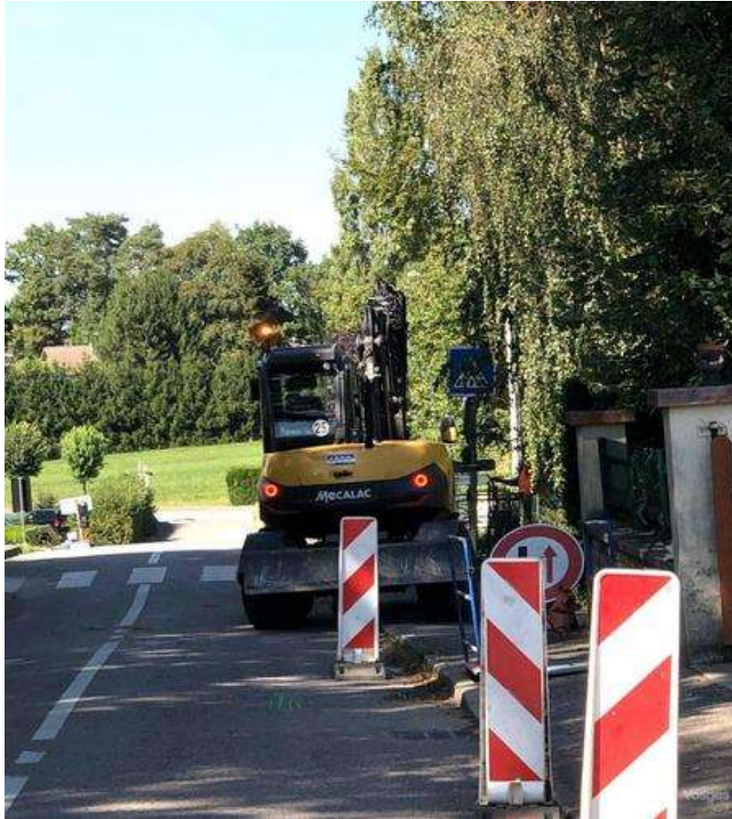
Les premiers coups de pelle de l'aménagement de la route de Renauvoid ont été donnés.
