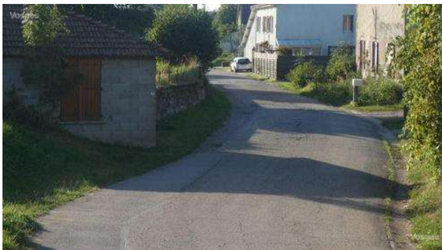
La rue de l'Avière va connaître un chantier de rénovation de voirie dans les semaines qui viennent.
