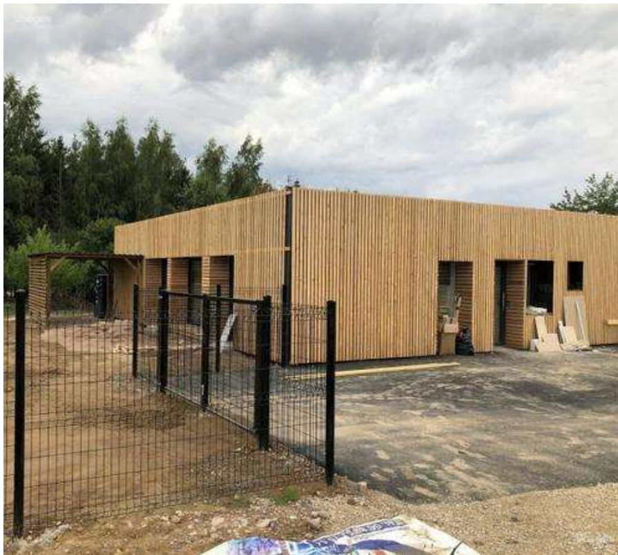
La crèche Calinou est pratiquement terminée, tant à l'intérieur qu'à l'extérieur.
