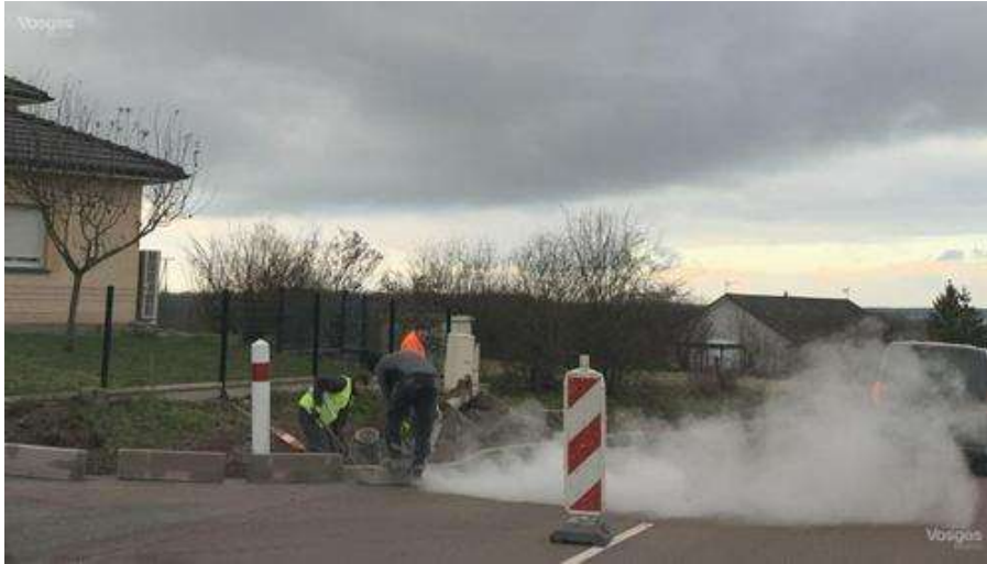
L'entreprise Valdenaire effectue actuellement la pose de trottoirs, rue de la Libération, côté Uxegney.
