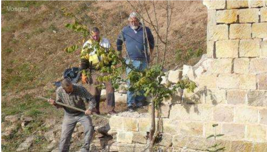
Un des gros chantiers de l'année, la réfection du fort qui, au fil des ans, s'est écroulé.
