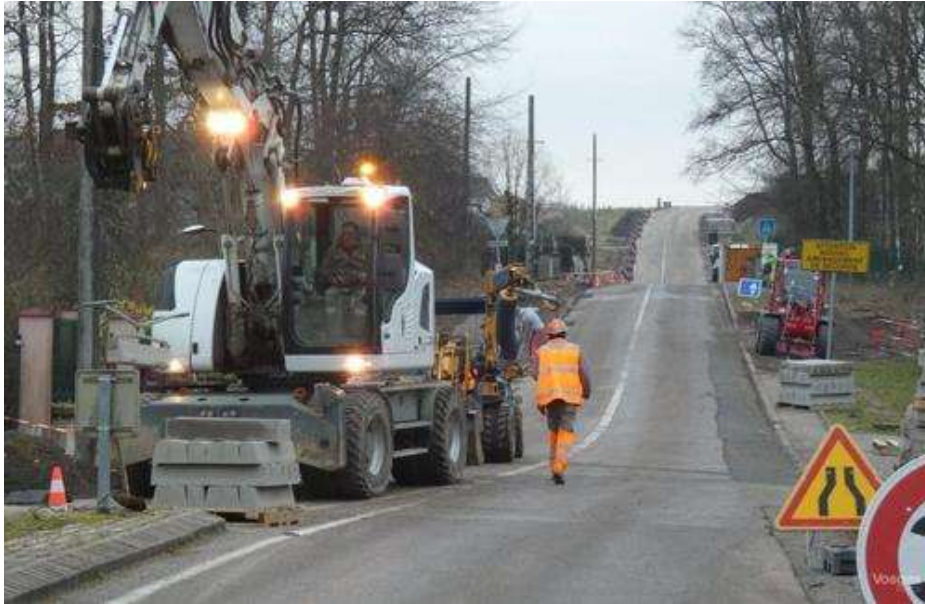
Le chantier de la rue de Renauvoid, qui devrait durer six mois, a débuté par la pose de trottoirs.
