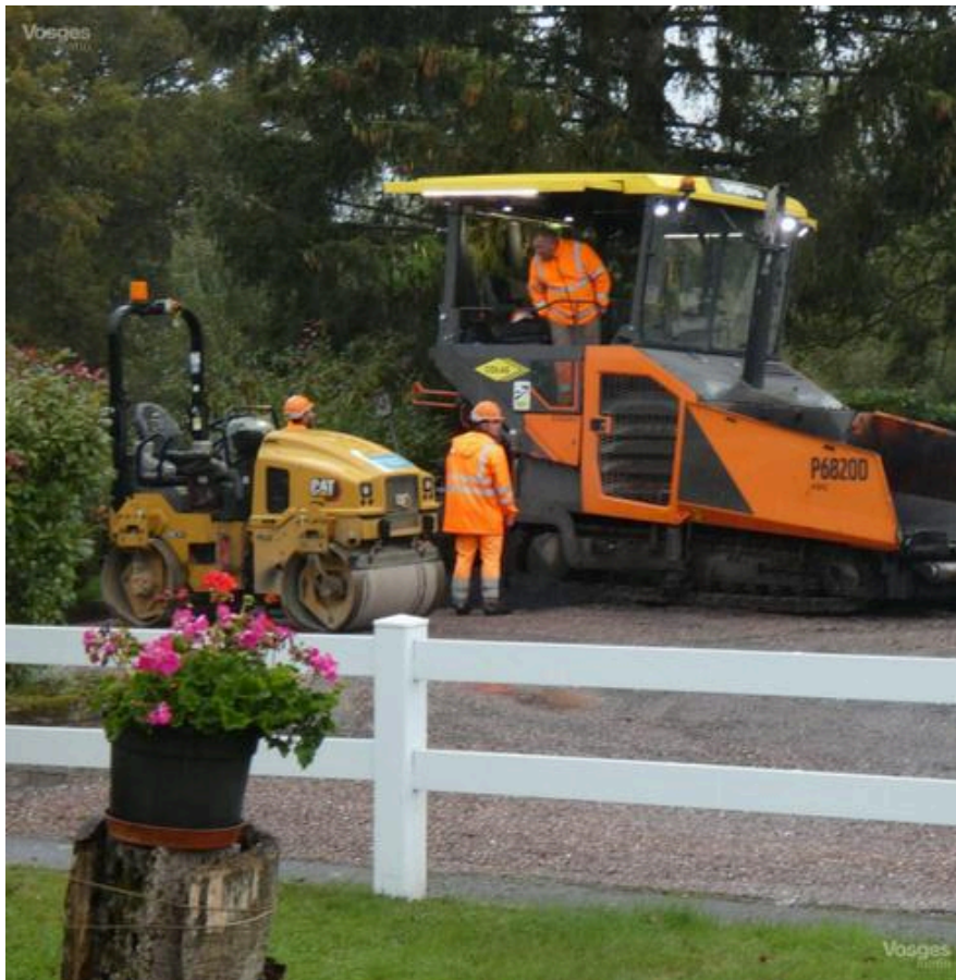
Le macadam est posé en bas du lotissement.
