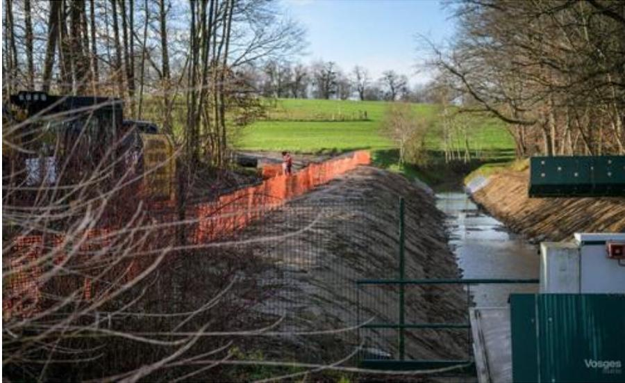
*Les travaux d'étanchéité du canal d'alimentation de Bouzey vont bon train, notamment sur le ban communal de Sanchey, entre la route de Renauvoid et le déversoir donnant sur le réservoir dont le niveau d'eau devrait rapidement augmenter encore. Photo Jérôme Humbrecht Pour ces travaux d'étanchéité du canal d'alimentation de Bouzey à Sanchey, c'est la technique dite de la géomembrane qui a été choisie par VNF. Photo Jérôme Humbrecht*
